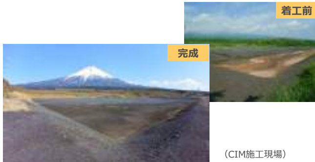
（CIM施工現場）
