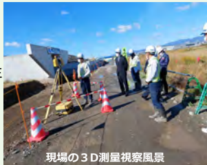
現場の3D測量視察風景
