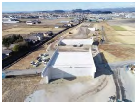
部長表彰受賞当該工事現場
